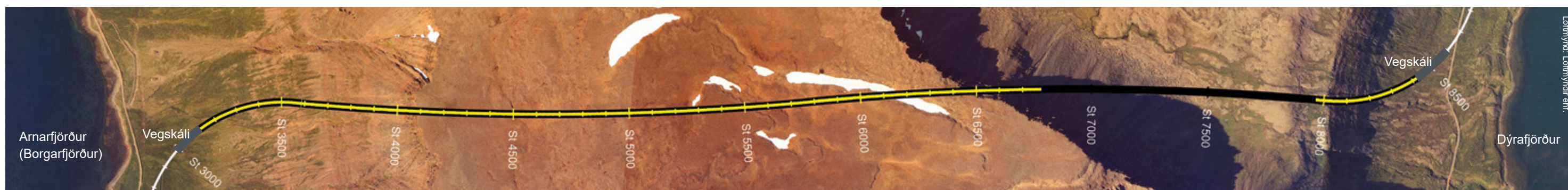
Dýrafjarðargöng, staða framkvæmda 7. janúar 2019. Búið er að sprengja samtals 4.103 m.
